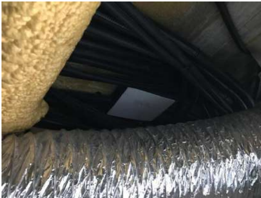
Fig. 27 Registro de planta tercera. Los tubos se desplazan hacia la izquierda.
