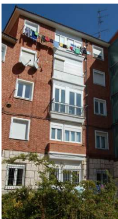
Imagen 1: Elementos volados en fachada
